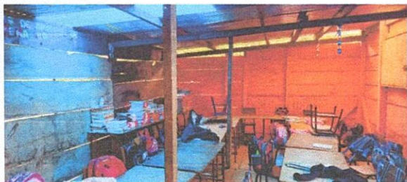
Foto1: Interior del módulo
